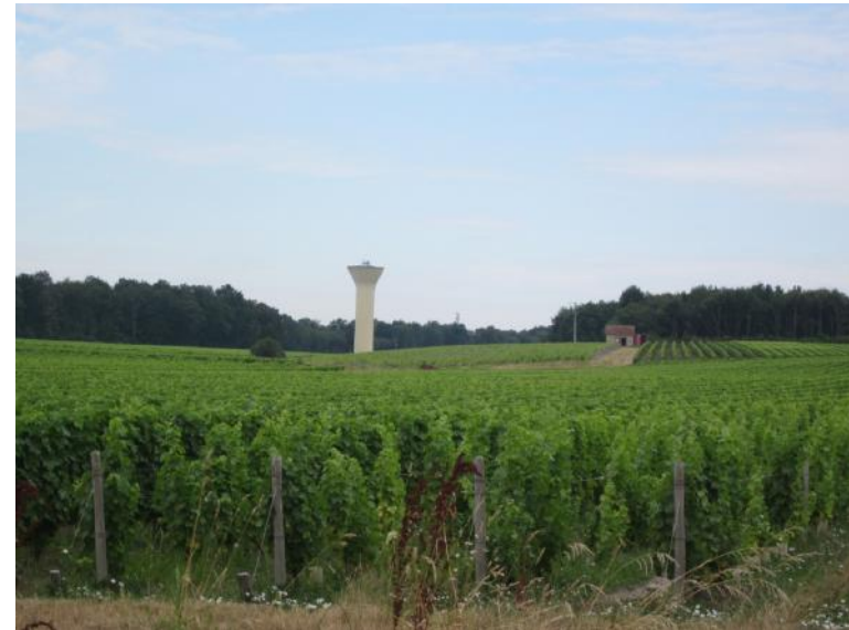
Château d'eau à Chémery (Source : G2C)
