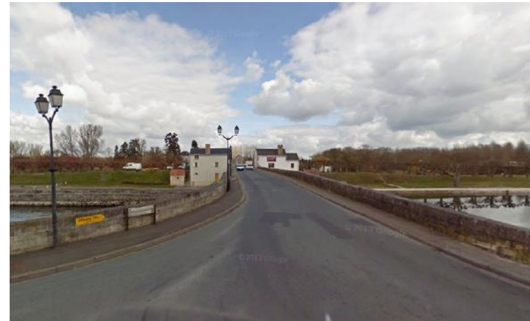
Traversée du Cher au niveau de Saint-Aignan (Source : Google Maps)
