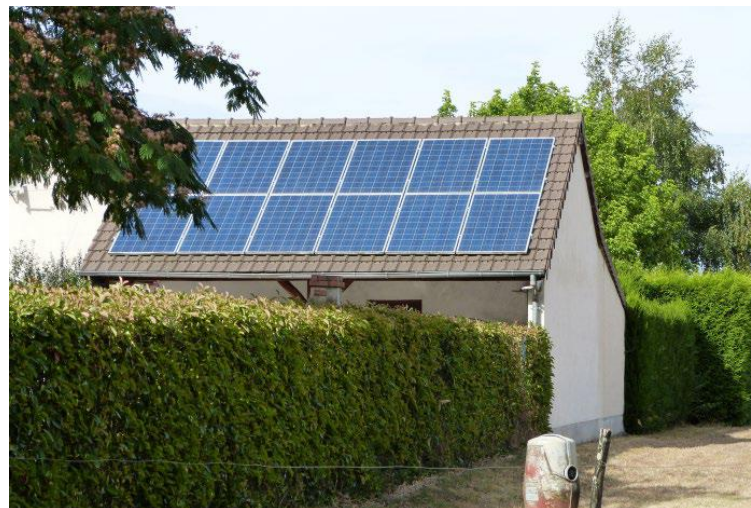
Panneaux solaires sur toiture à Châtillon-sur-Cher (Source : Biotope)
